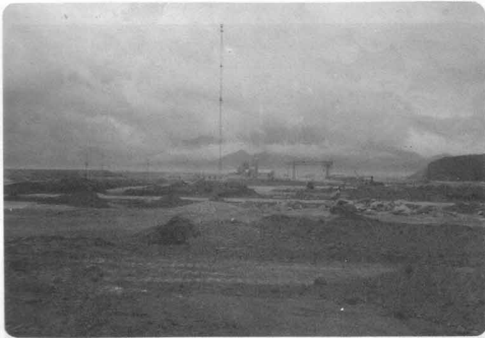
照片四：大亞灣核電廠平整廠地情況，照片最前面即為反應堆位置。
